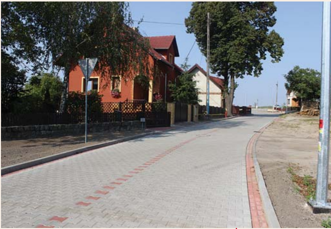
Budowa drogi gminnej w Niałku Wielkim
