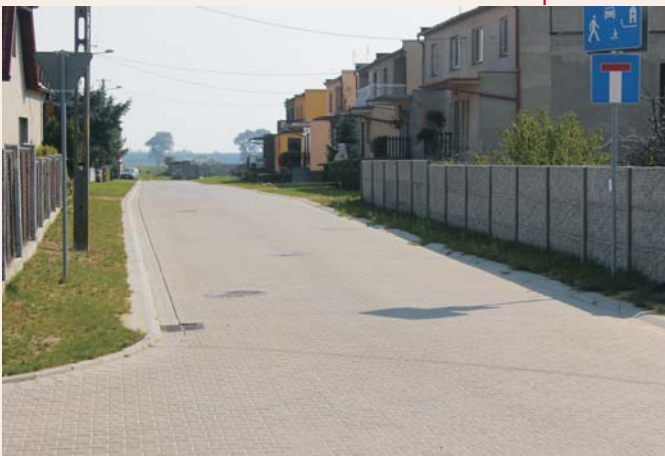
Budowa dróg we Wroniawach: ul. Spokojna
