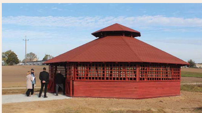
Budowa wiaty rekreacyjnej w Niatku Wielkim
