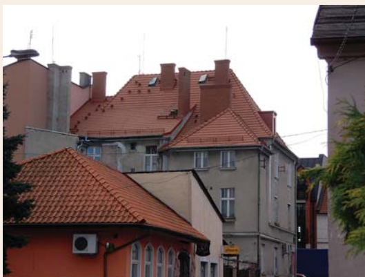
Remont dachów na ul. Dr. Kocho w Wolsztynie
