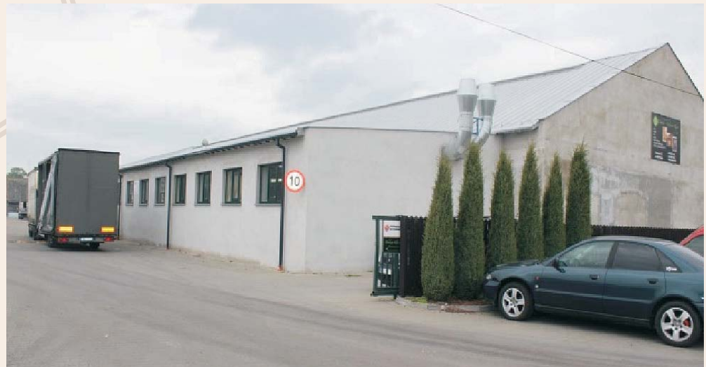
Rozbudowa zakładu stolarskiego Usługi Zakład Stolarski Józef Rzepa w Chorzeminie
