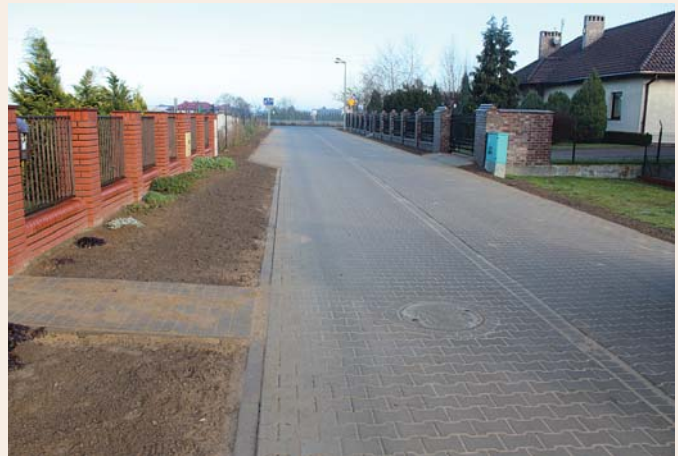
Przebudowa dróg gminnych w obrębie Komorowa
