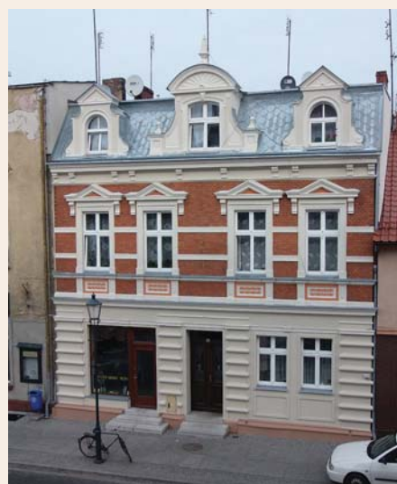
Wyremontowana elewacja budynku na ul. Poznańskiej w Wolsztynie
