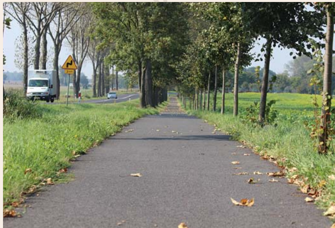
Remont ścieżki rowerowej z Niałka Wielkiego do terenów rekreacyjnych nad J. Świętym
