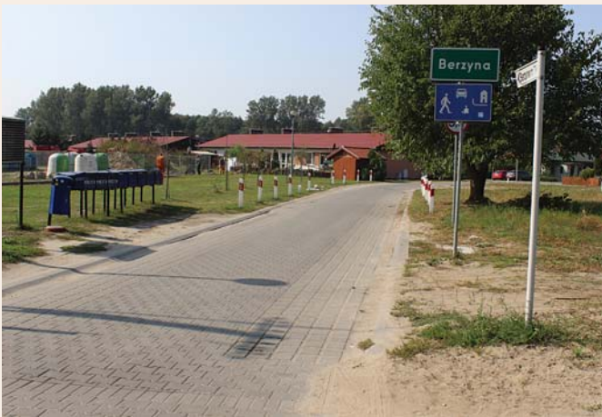
Budowa dróg na osiedlu budownictwa mieszkaniowego na Berzynie
