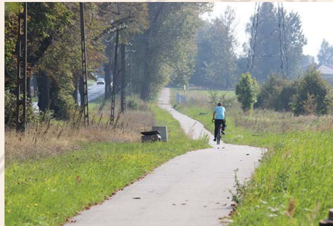
Remont ścieżki Wolsztyn - Stary Widzim
