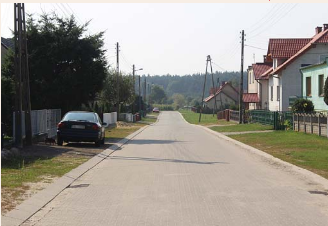
Budowa dróg w Obrze (m.in. ul. Łąkowa, ul. Kręta, ul. Wąska, ul. Św. Anny, ciąg pieszo-jezdny Obra-Nowa Obra)
