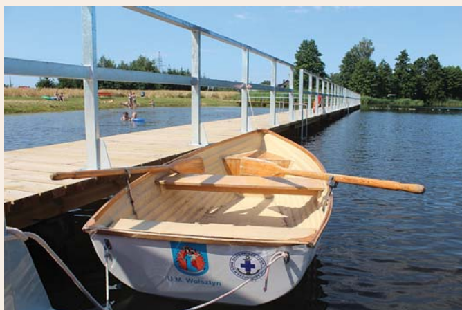
Budowa infrastruktury turystyczno-sportowej nad Jeziorem Krutla w Obrze
