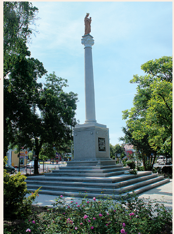
Remont figury i nawierzchni na Placu Kościuszki
