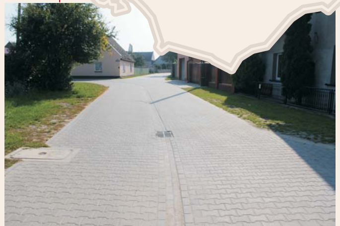
Budowa dróg w Kębtowie: ul. Łąkowa i ul. Kręta
