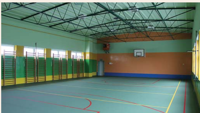
Wyremontowana sala gimnastyczna w Starym Widzimiu
